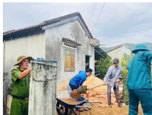
Lực lượng công an xã tổ chức hỗ trợ, đóng góp ngày công thực hiện xây nhà tạm, nhà dột nát. Ảnh: CTV
